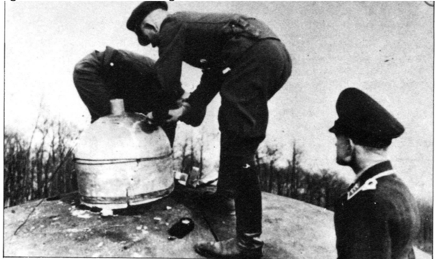
Figure 14: Essai charge creuse sur B8 du Métrich
