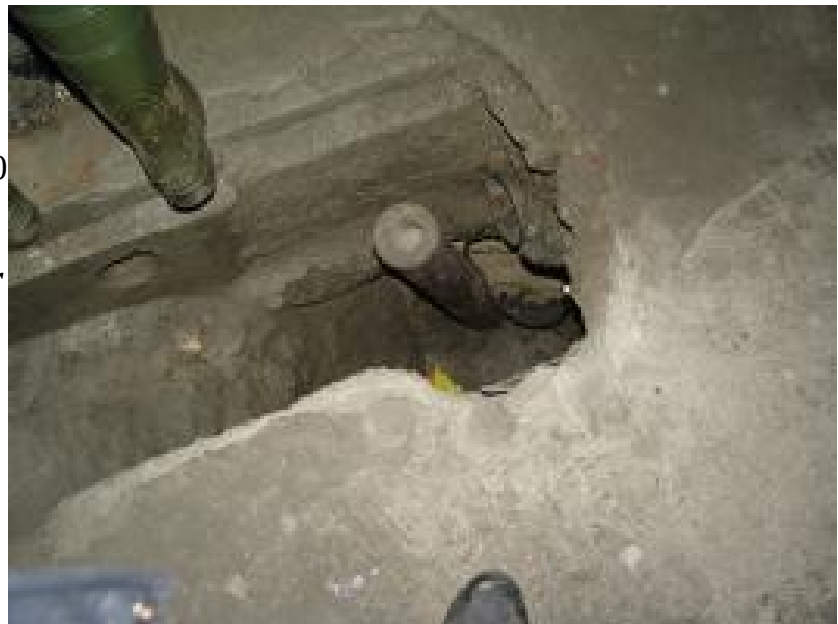
Figure 8: Fort d'Aubin-Neuchâteau Obus Röchling fiché dans le radier d'une galerie
