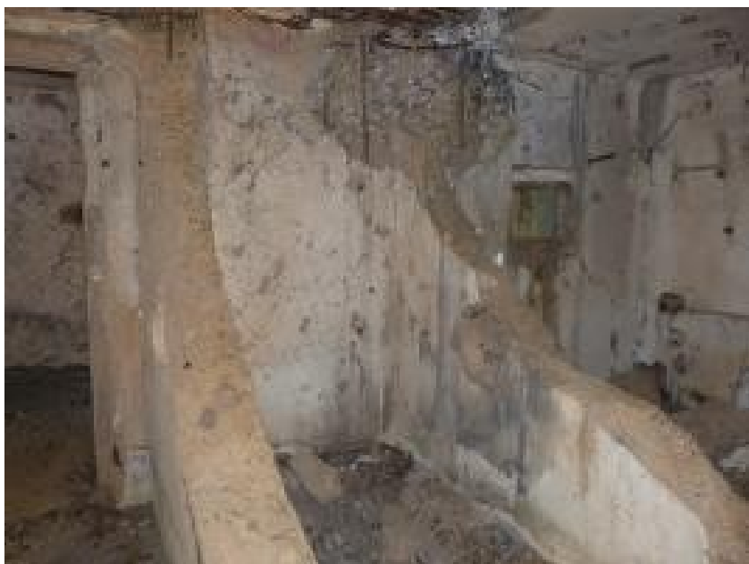
Figure 9: Casemate de Sapogne. Résultat du tir d'essai Röchling . Photo David Harmand
