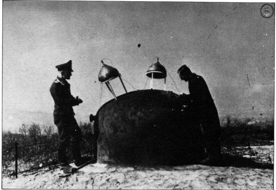
Figure 13: 1941 Essai charge creuse sur cloche GFM du Métrich
